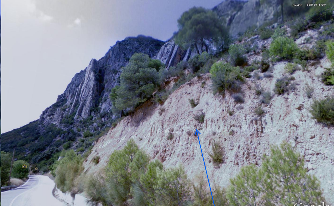
Algo antes, en el talud, niveles margo-arenosos blanquecinos muy inestables , distintos de los de pié de monte , caídos por la pendiente y sin ordenación
