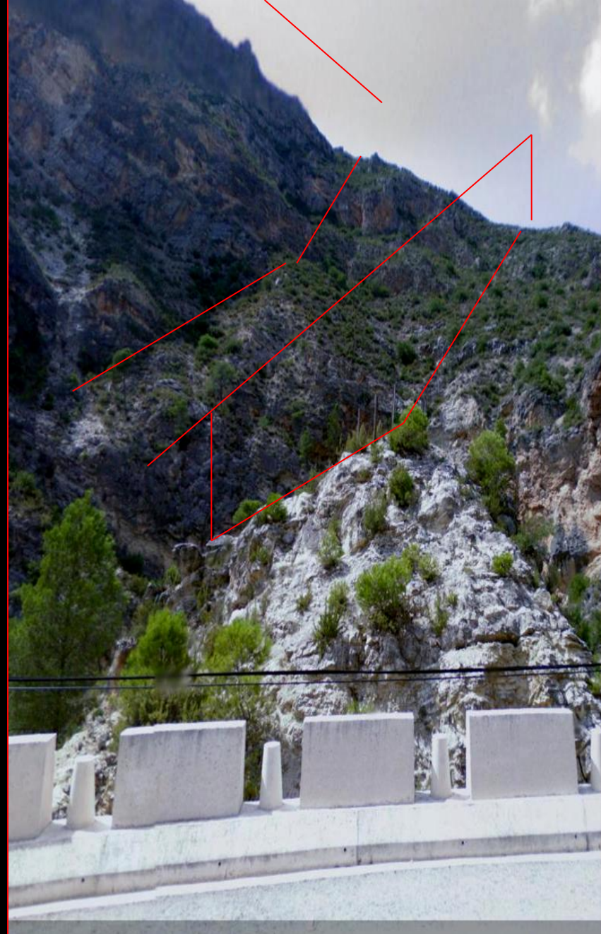
Zona de fallas en ladera SW de la carretera cerca del puente
