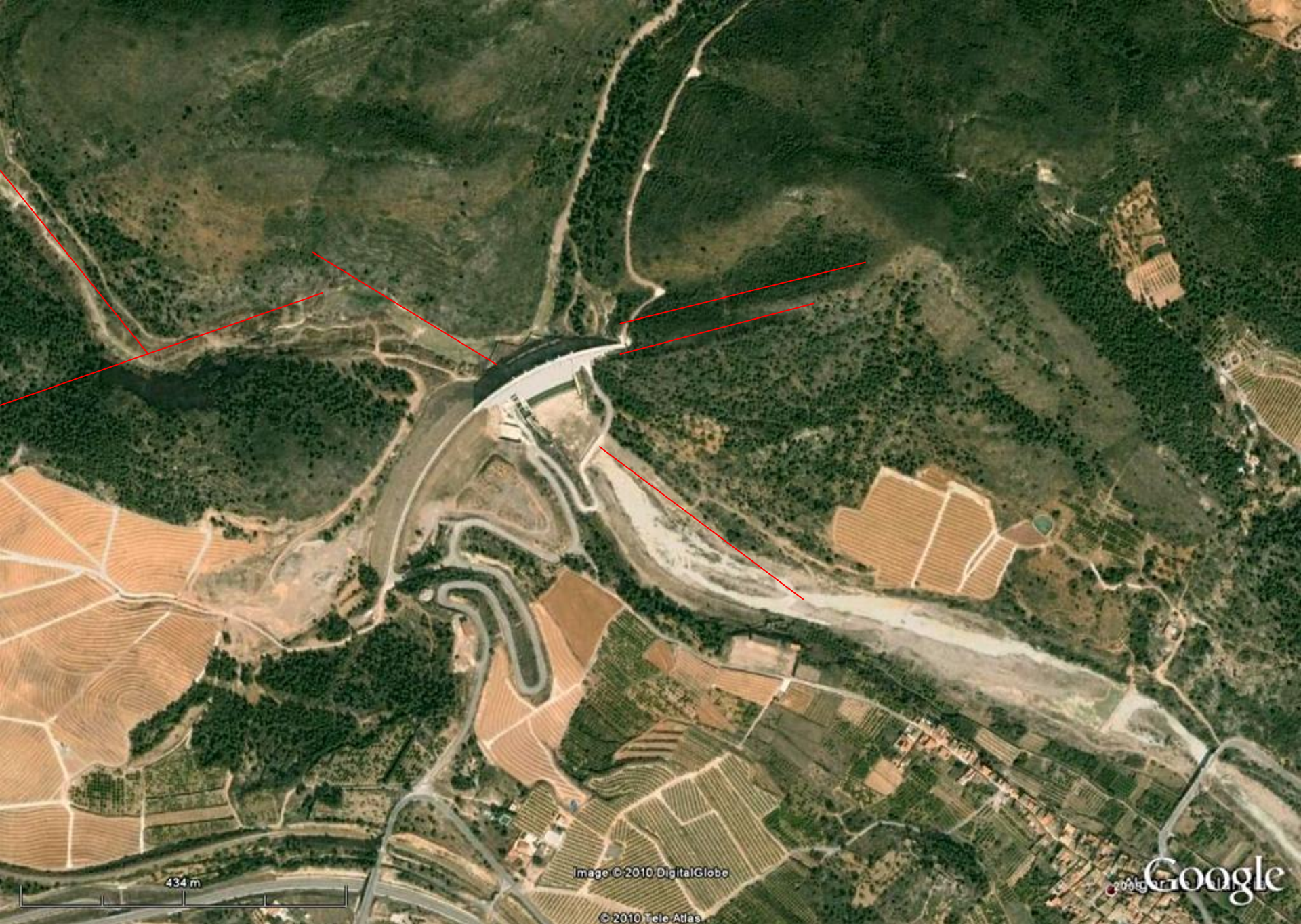
Presa de Algar del Palancia. Valencia.
